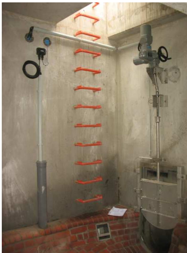
Abb.1: Elektroregelschieber im Drosselbauwerk.
